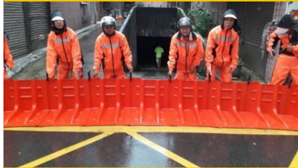
0520豪雨前老舊公寓地下室入口預佈防洪版減災
