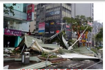
招牌毀損掉落傷及行人
