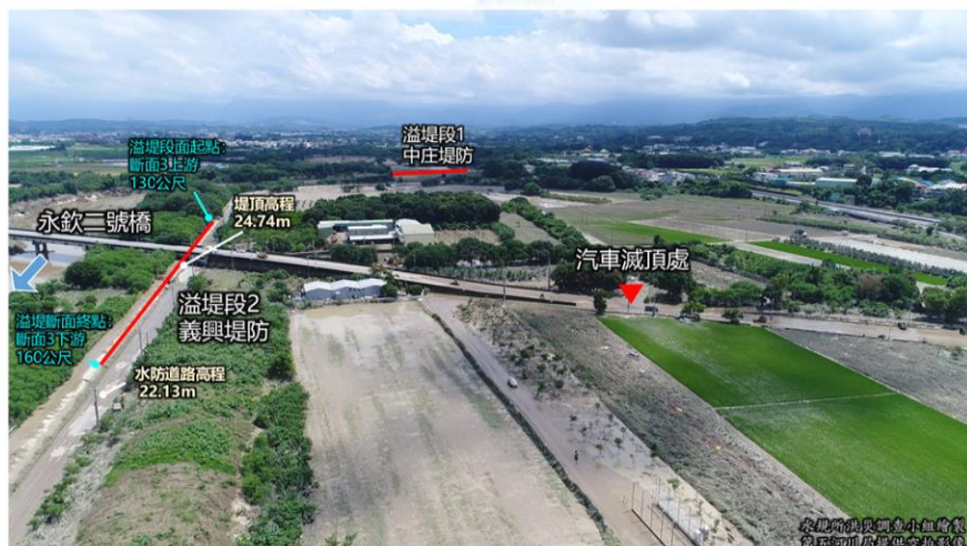
災點1-1：永欽二號橋河段左岸(溢堤段1)
