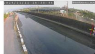
屏東 羌園排水分洪道
