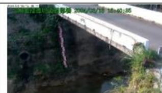
福德坑溪福德橋
