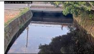
新屋區 大堀四號橋站
