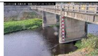
永康大洲一號橋
