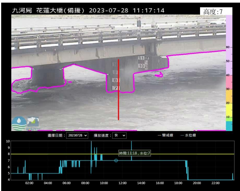
第九河川分署花蓮大橋
