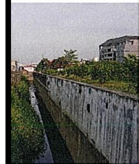
建國排水--排水路、保護工--正常(建國)
